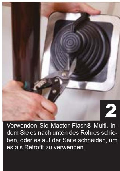
Verwenden Sie Master Flash® Multi, indem Sie es nach unten des Rohres schieben, oder es auf der Seite schneiden, um es als Retrofit zu verwenden.
