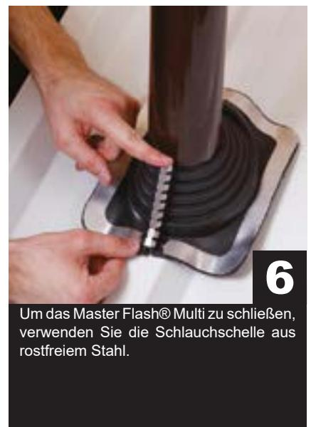
Um das Master Flash® Multi zu schließen, verwenden Sie die Schlauchschelle aus rostfreiem Stahl.
