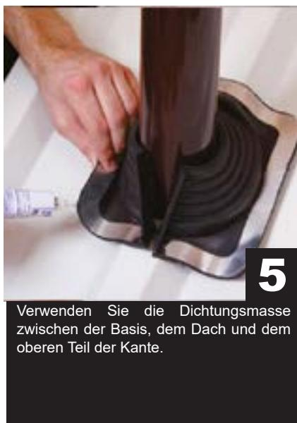
Verwenden Sie die Dichtungsmasse zwischen der Basis, dem Dach und dem oberen Teil der Kante.
