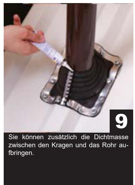
Sie können zusätzlich die Dichtmasse zwischen den Kragen und das Rohr aufbringen.
