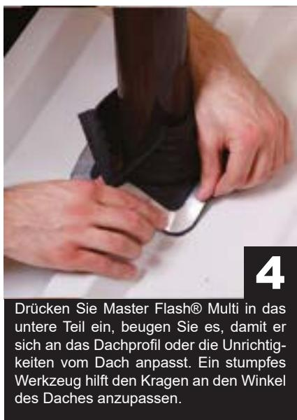
Drücken Sie Master Flash® Multi in das untere Teil ein, beugen Sie es, damit er sich an das Dachprofil oder die Unrichtigkeiten vom Dach anpasst. Ein stumpfes Werkzeug hilft den Kragen an den Winkel des Daches anzupassen.
