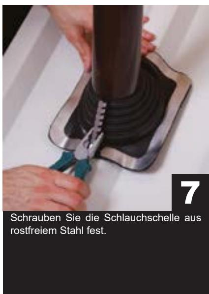
Schrauben Sie die Schlauchschelle aus rostfreiem Stahl fest.
