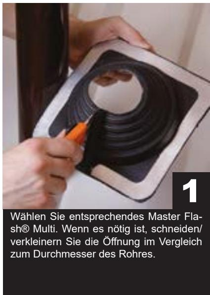
Wählen Sie entsprechendes Master Flash® Multi. Wenn es nötig ist, schneiden/verkleinern Sie die Öffnung im Vergleich zum Durchmesser des Rohres.
