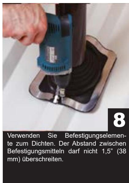
Verwenden Sie Befestigungselemente zum Dichten. Der Abstand zwischen Befestigungsmitteln darf nicht 1,5" (38 mm) überschreiten.
