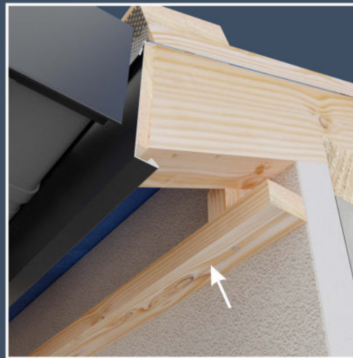
Montage des Befestigungsrahmens für die Laibung.
