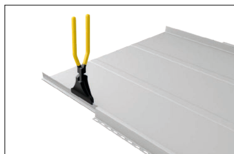
ABB. 22 Das Schloss wird auf beiden Paneeelseiten ausgeschossen
